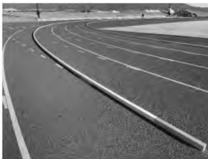
全線に設置した代用縁石【図 3】
