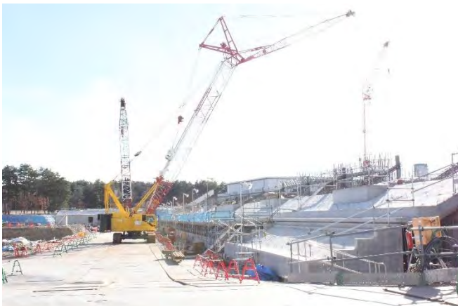
2024年12月6日 建設中のメインスタンド(長野陸協提供)
