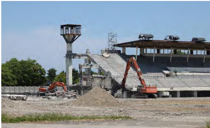
7 月 5 日現在のメイン競技場解体の様子
