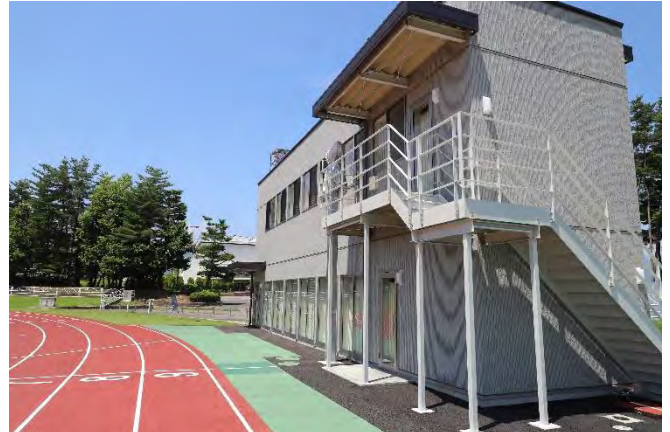
3 月に完成した写真判定棟：トラックスタート側から撮影
